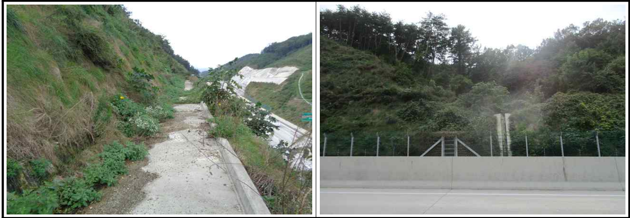
【그림 38.3.3】 배수시설 전경
